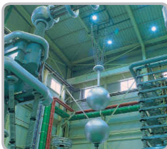
Испытание импульсом в лаборатории высоких напряжений
