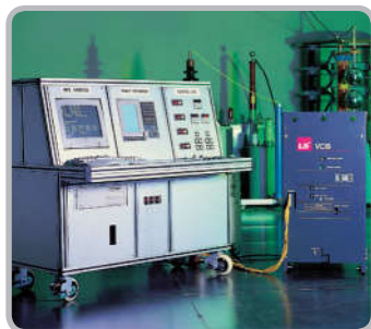
Проверка характеристик вакуумного автоматического выключателя
