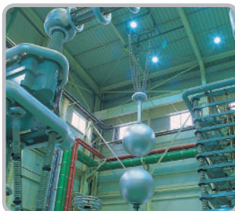
Испытание импульсом в лаборатории высоких напряжений
